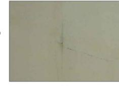
VISTA E: limitati distacchi dell'ultimo strato di finitura dell'intonaco
