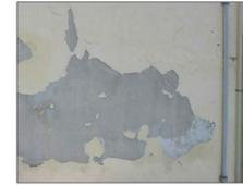
VISTA B: diffusi distacchi dell'ultimo strato di finitura dell'intonaco
