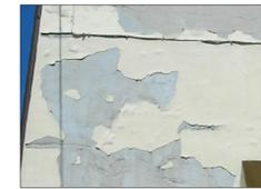
VISTA F: diffusi distacchi dell'ultimo strato di finitura dell'intonaco
